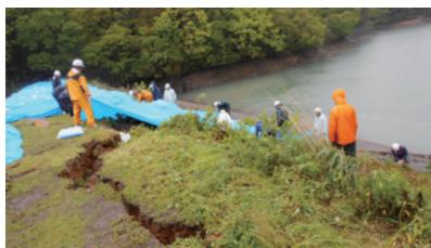
鎧ヶ鼻ため池の堤防に亀裂があり、応急処置する様子
