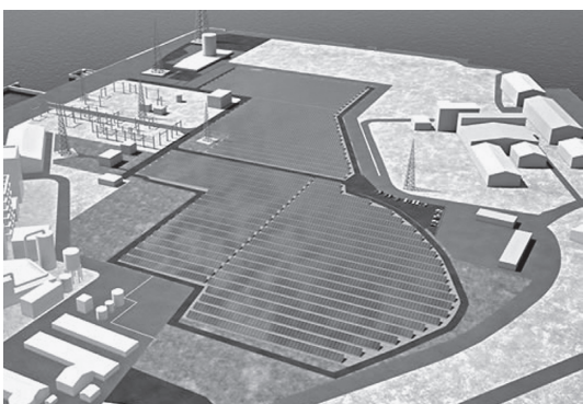
メガソーラー大牟田発電所
