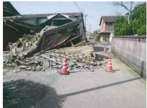
図 家屋倒壊による道路閉塞状況 出典：「平成 28 年熊本地震」の対応に係る検証（平成 30 年 3 月 宇城市）
