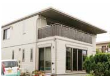
地盤改良し、新築した家 耐震診断などの調査結果から建て替えを決意した
