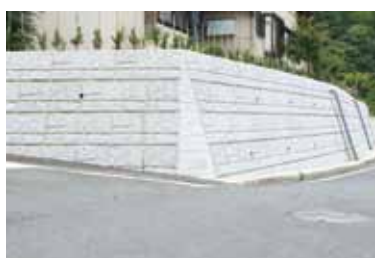
家の敷地を囲む頑丈な擁壁 自然災害から建物を守る
