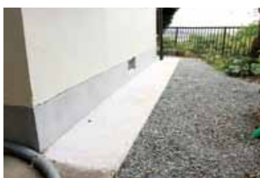
基礎の白い部分から先が沈下し、傾斜復旧をした
