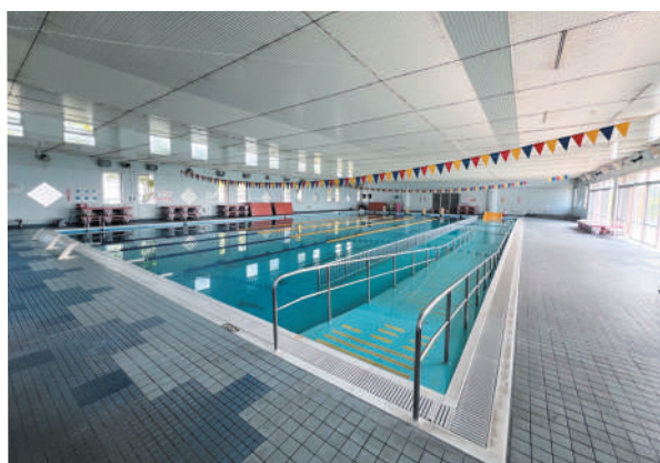
不知火温水プール
