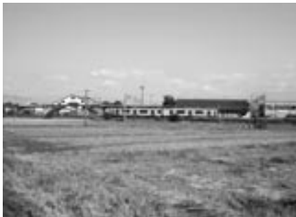
今後の開発が期待される松橋駅周辺（駅裏より駅舎を臨む）
