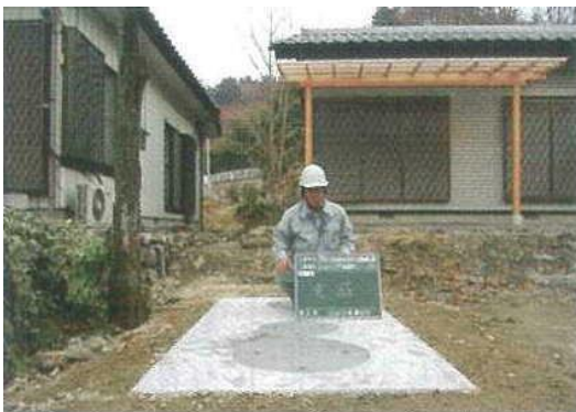
【写真10】 工事完了の写真
