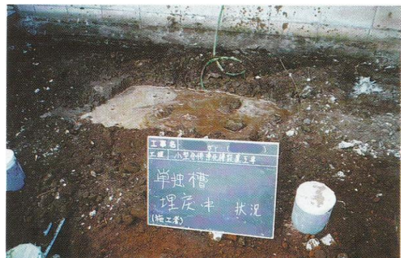
(5) 埋め戻し作業の写真
