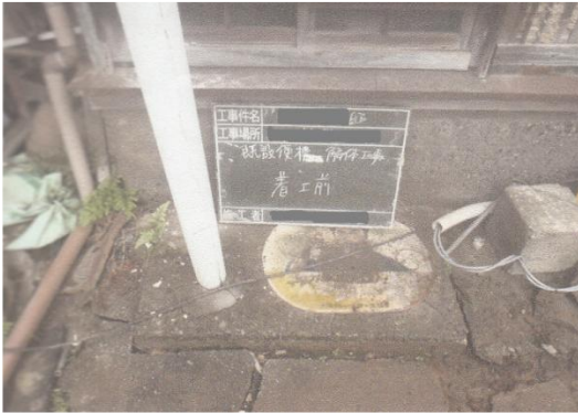
(1) 工事着工前の写真
