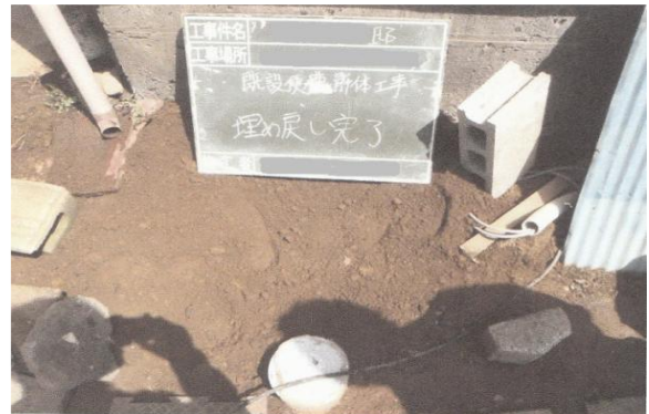
(6) 工事完了の写真
