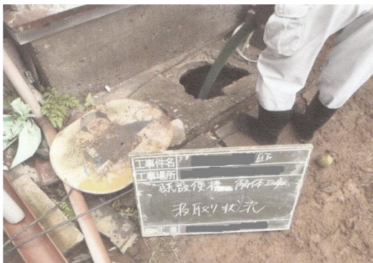
(2) 汚泥くみ取作業の写真
