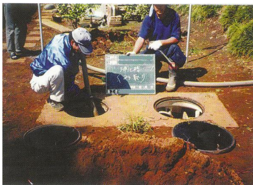
(2) 汚泥くみ取作業の写真
