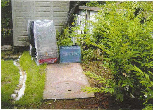
(1) 工事着工前の写真
