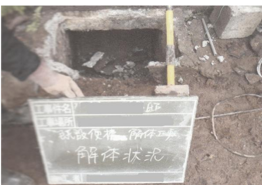
(4) 解体又は掘上作業の写真
