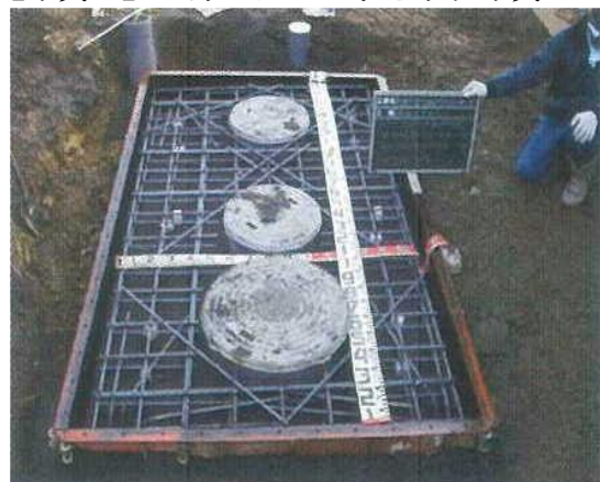
【写真7】上部スラブ工事を示す写真
