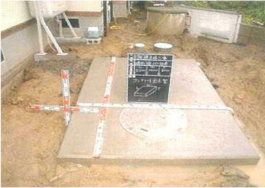
【写真8】 上部スラブコンクリート状況を示す写真
