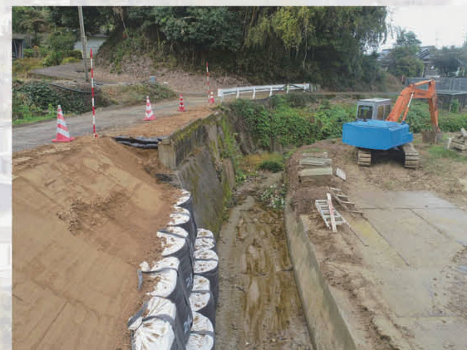
(豪雨災害の被災箇所の復旧工事)
