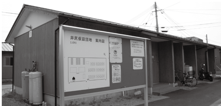
井尻仮設団地
