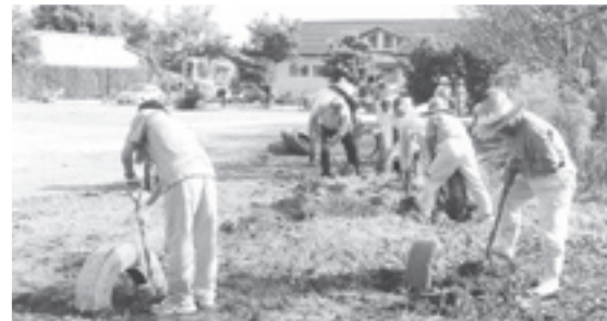
江頭多目的広場整備作業
