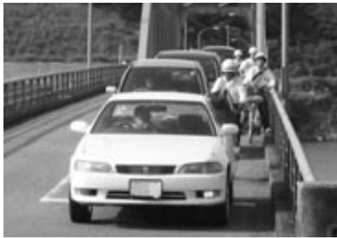
歩道が無く危険な状態となっている戸馳大橋
