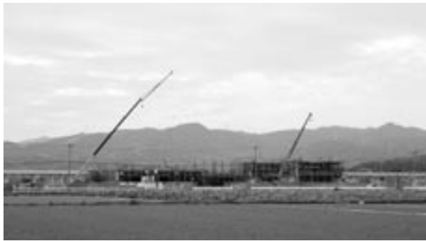
着々と工事が進む仮称宇城南署
