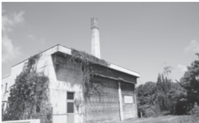
旧三角町ごみ焼却場
