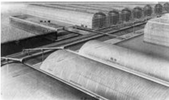
連棟ビニールハウスの雨樋を利用した雨水貯留施設
