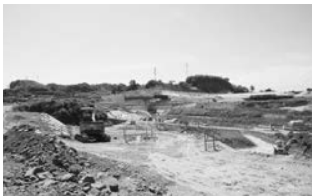
宇城氷川スマートインターチェンジ工事風景
