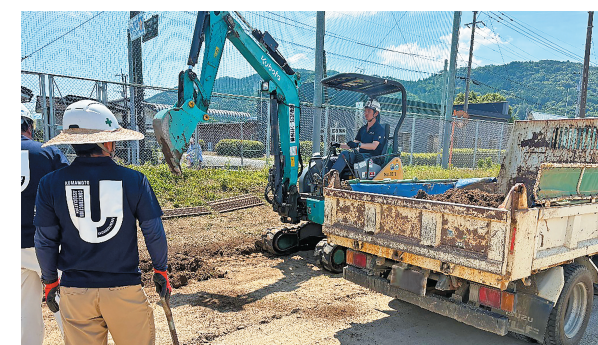
バックホウで側溝の泥をかき出す作業員たち
