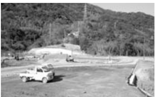
建設中の三角小学校と体育館予定地
