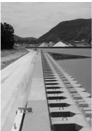
護岸延長140m、面積964.61㎡が造成されました
