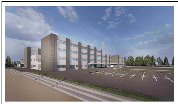
松橋中学校校舎等建替事業
