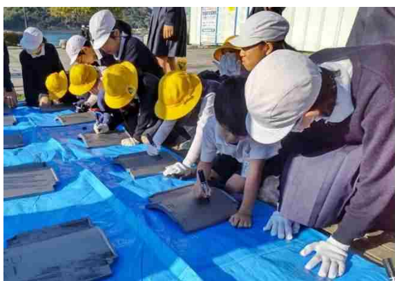
龍驤館耐震補強工事 三角小学校児童による瓦の名入れ
