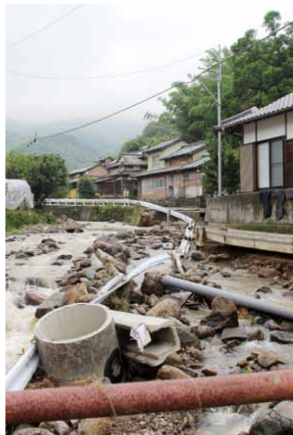
市では、9,488世帯 24,466人に避難勧告が発令され、大見川沿いの道路も流されてしまいました。
