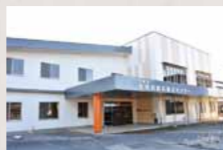
※公民館の解体工事のため、当面、車で来館はお控えください。
