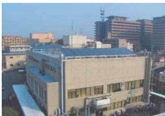
太陽光発電（上下水道局別館）
