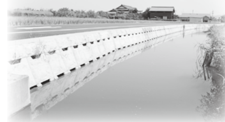
環境に配慮した工事の施工例
