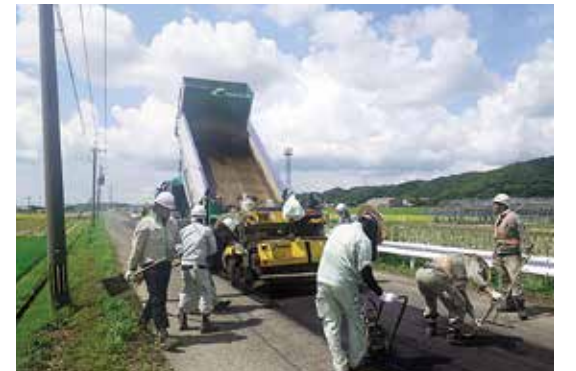
猛暑の中、丁寧な補修作業
