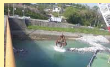
平成26年度 橋台工事
