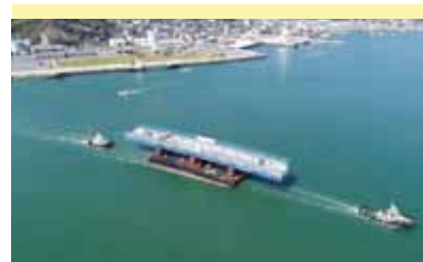
平成29年度 上部工工事
