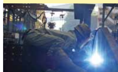
平成25年度 橋脚工事
