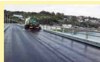
平成30年度 舗装工事
