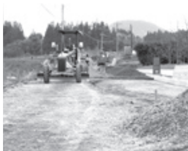
補修工事中の市道
