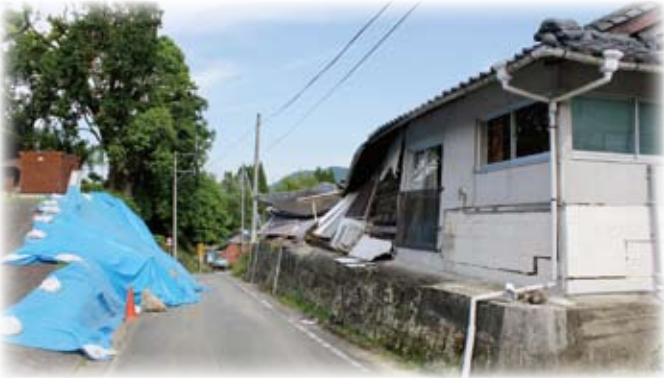
建物や法面に被害を受けた豊野町下郷地区
