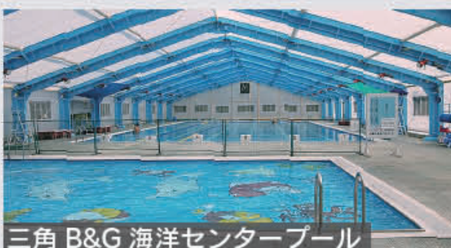
三角 B&G 海洋センタープール
