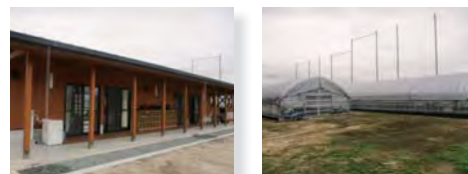
南側グラウンドにできた作業棟と農業用のハウス
