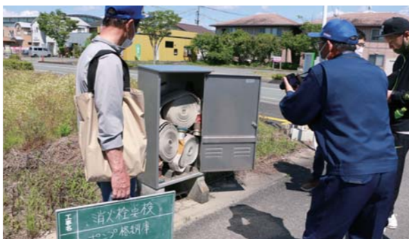
各地に設置されている消火栓、格納箱を点検
