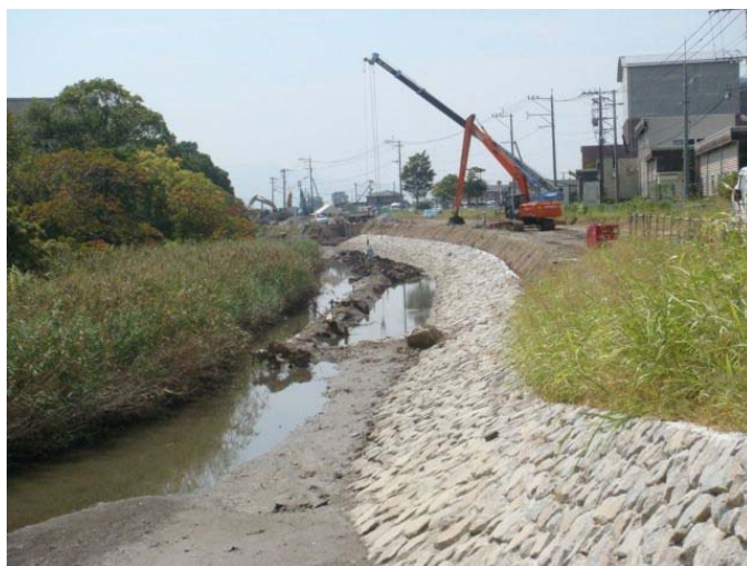
大野川河川改修
