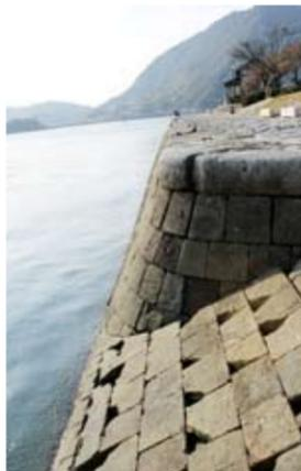
石工たちは均一の大きさに切り分け、角を取って曲面に仕上げると、持っている技術を余すところなく用いて港を築き上げました。総延長756メートルにも及ぶ埠頭は、まさに「圧巻」の一言に尽きます。
