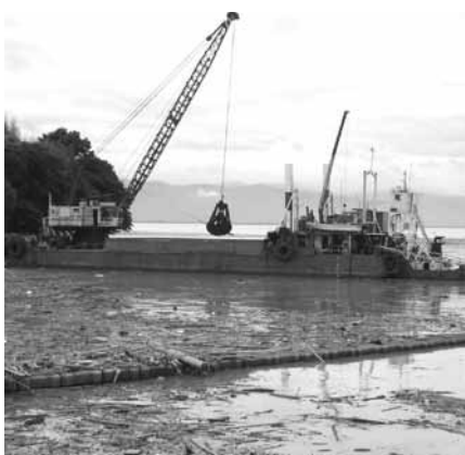
台船による漂流ゴミの撤去作業
