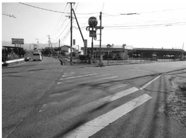
左が国道3号、右が市道に分かれる北新田交差点
