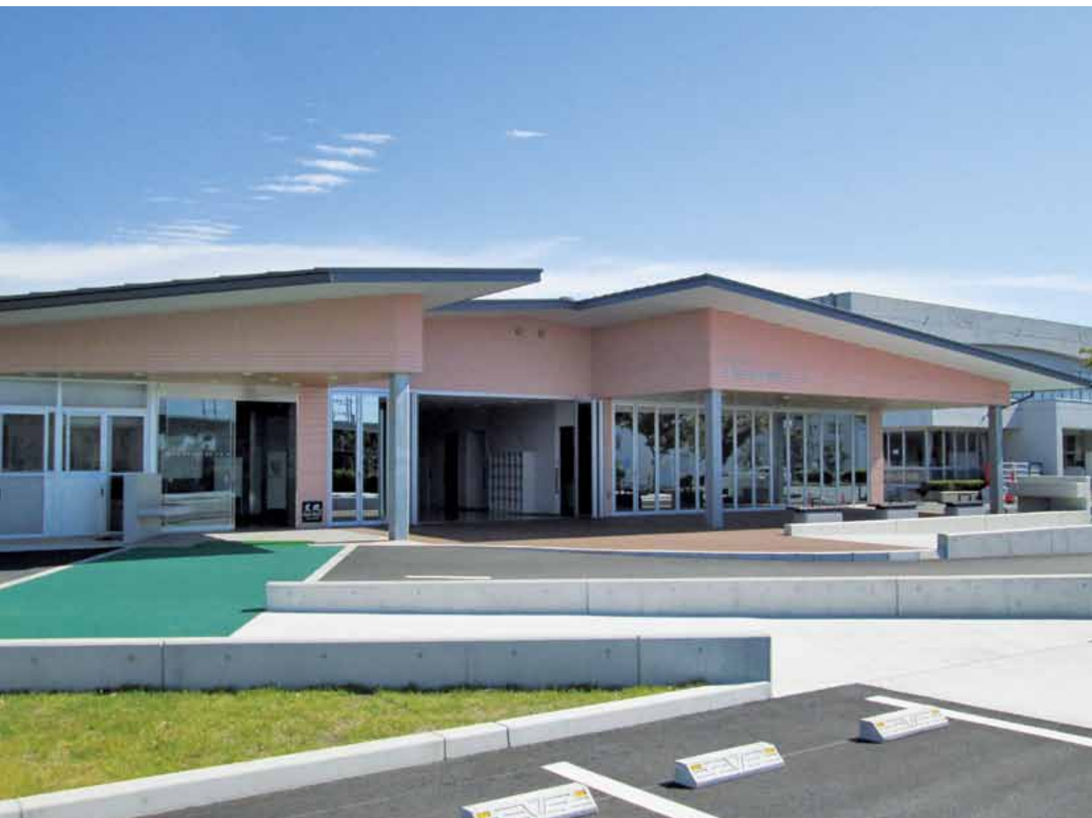
不知火防災拠点センター
