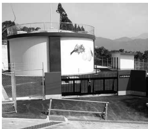
水道施設（配水池）
