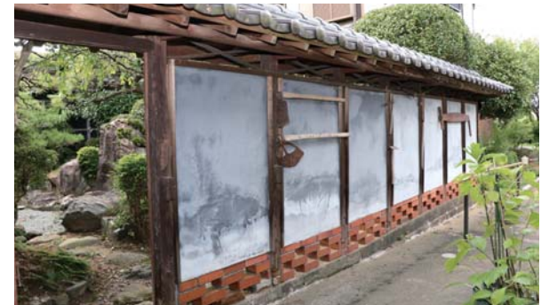
熊本地震で被災したが補助事業により復元された中庭堀
