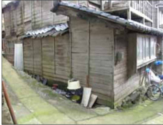
外壁が裸木造の例
