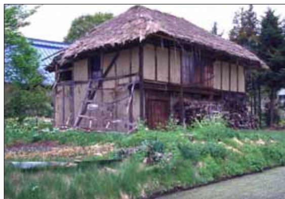
屋根材がワラの例
