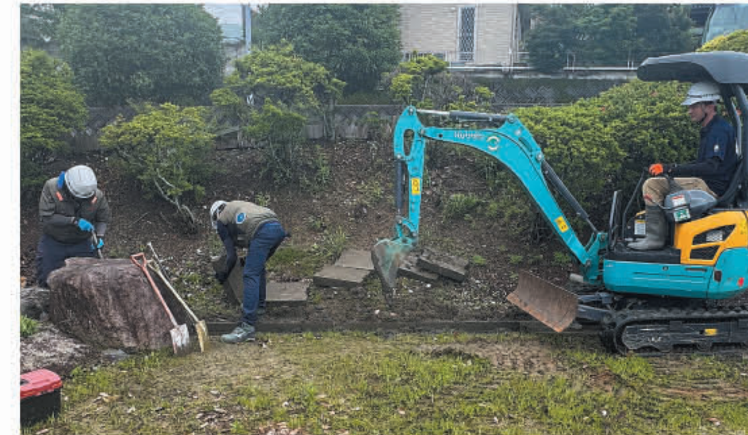
側溝の蓋を1枚ずつ外して、堆積した泥をかき出した
