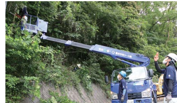
高所作業車を使用し樹木を伐採
