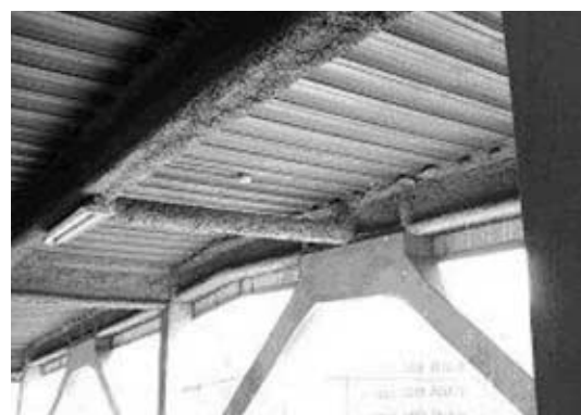
▲吹き付けアスベストの施工例
