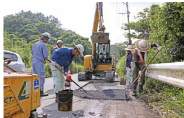
アスファルトを敷き詰める組合員の皆さん
