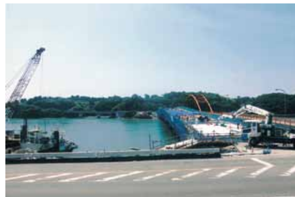
生コンクリートの注入作業が行われていました
