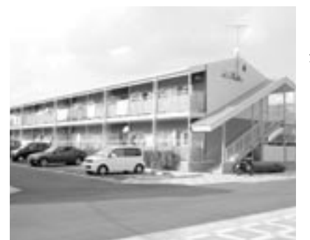
準PFIにより建設された鹿児島県加治木町の黒川住宅
