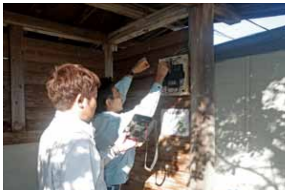
屋外のプレーカーも一つ一つ点検しました
