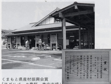
くまもと県産材振興会賞 「アグリパーク豊野 青空市場」 施主：宇城市 設計：(株)宮田設計 施工：(株)松崎建設 延床面積：278.96㎡ 県産材使用量：85.3㎡ 主な使用樹種：スギ
