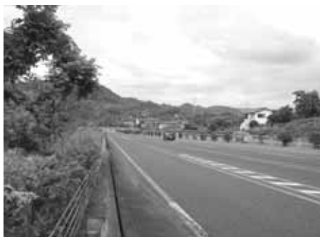
スマートインターチェンジ建設予定地の小川バス停
