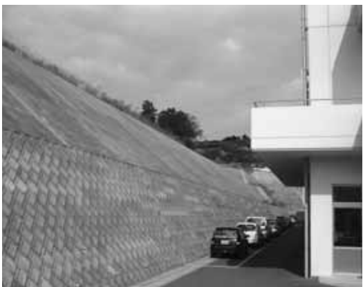
三角中学校校舎裏の法面
