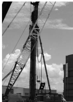
来年3月竣工に向けて建設が進む庁舎別棟
