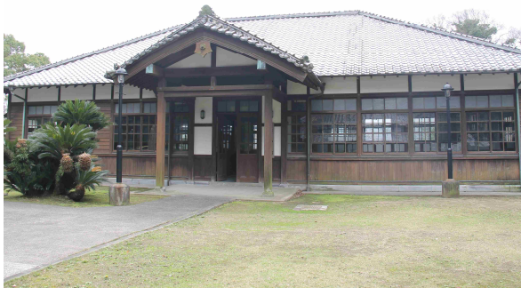
旧三角簡易裁判所 本館
