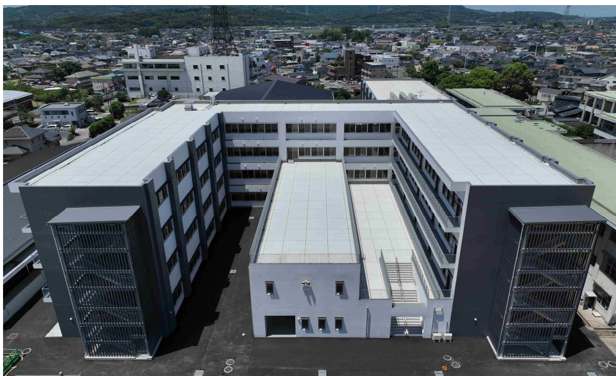
松橋中学校新校舎
