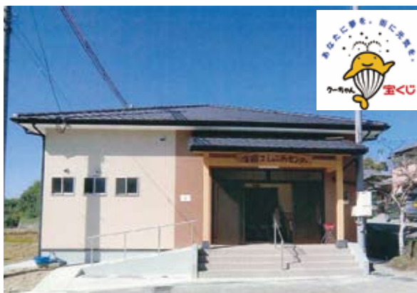
建設された宮園公民館
