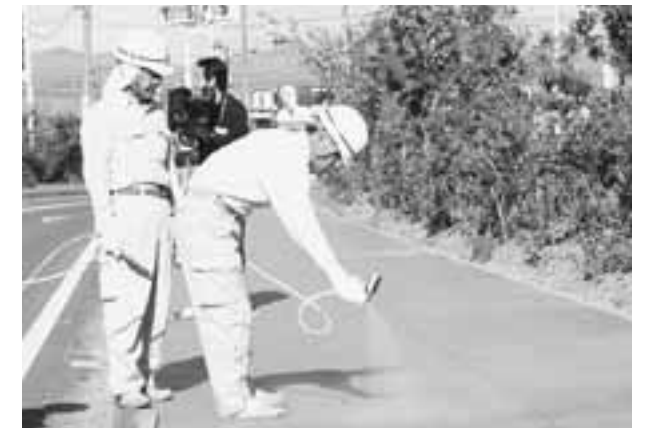
光触媒の塗布作業
