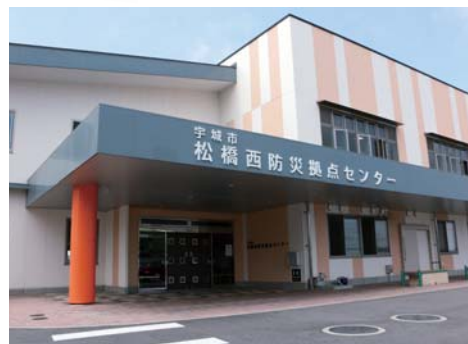
松橋西防災拠点センター
