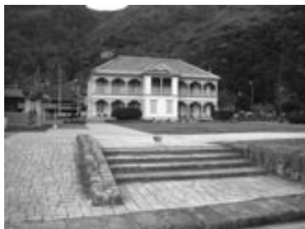
三角西港(海側から見た浦島屋)
