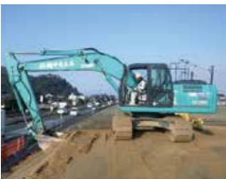
人が操作を行うのは前進後進のみ自動でのり面を締め固めて整形
