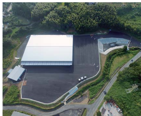
巨大な倉庫から、スーパーや小売店などへさまざまなモノを運ぶ中継地点
