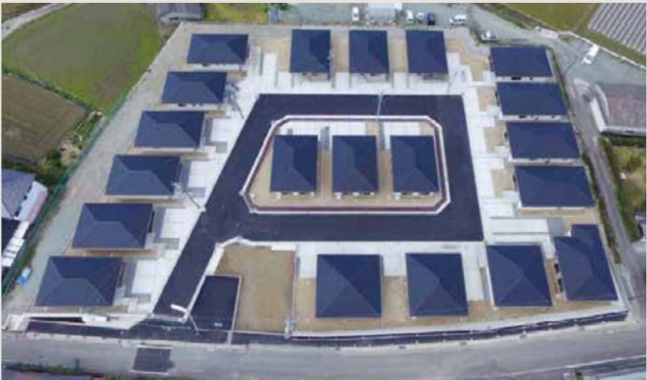
完成したばかりの小野部田復興住宅。タイプの異なる20戸が立ち並んでいる
