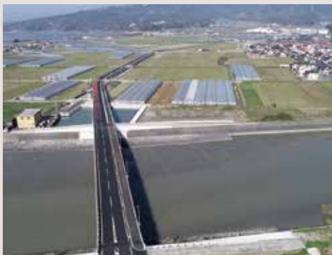
県道八代不知火線と国道266号(奥)を結ぶ
