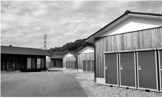
当尾仮設住宅
